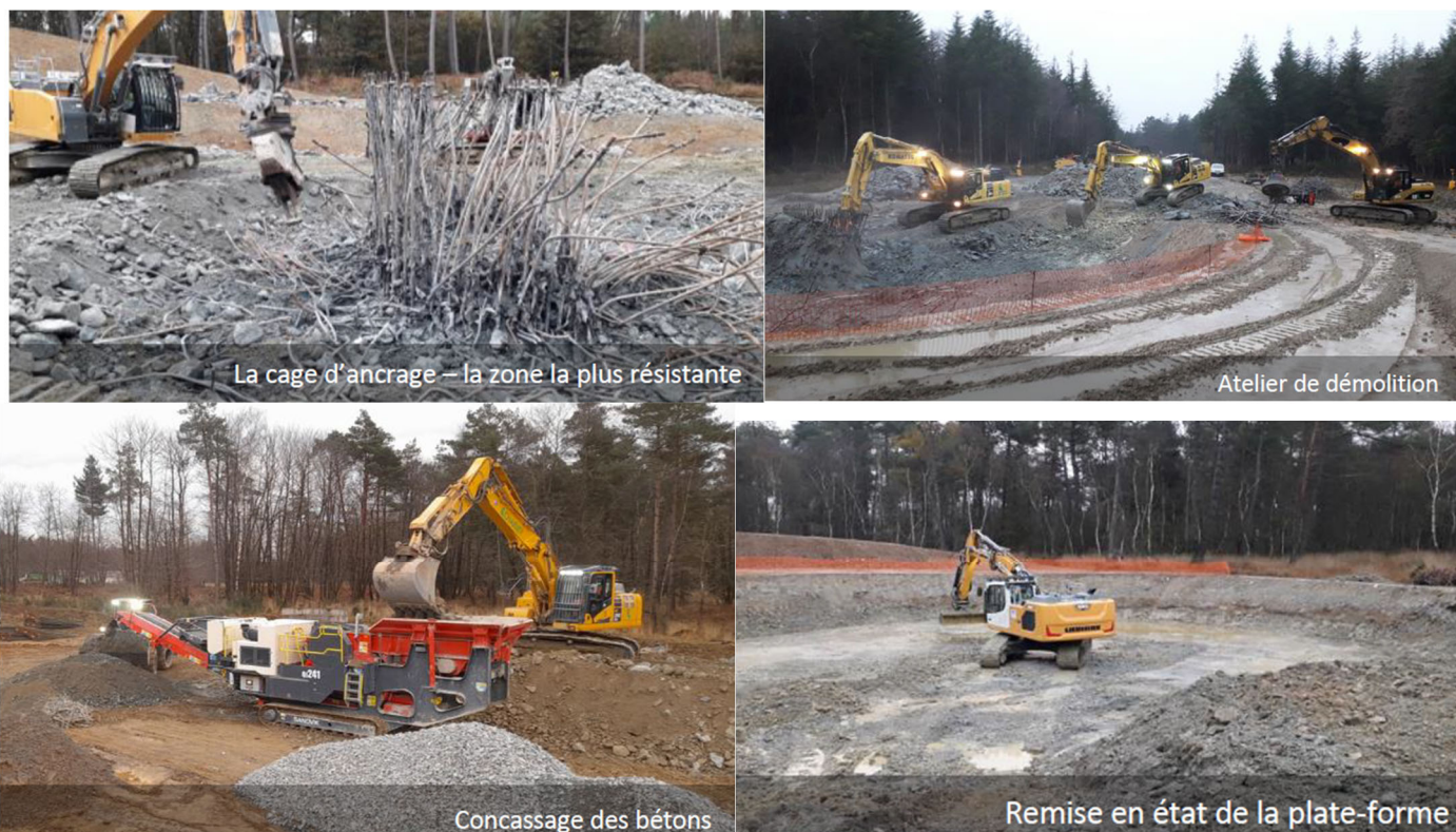
Figure 28 Déconstruction d'un socle d'éolienne (entreprise Charier)
